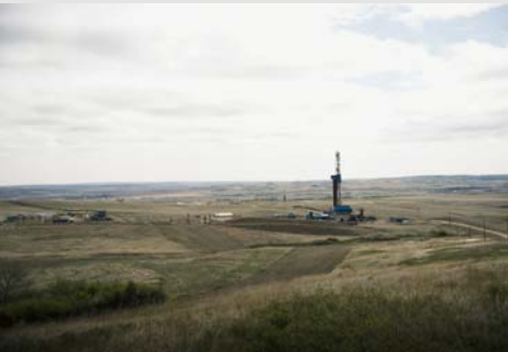
Bild 1: Bohrturm in Nord-Dakota (USA) Schiefer-Bassin betrieben von Statoil
